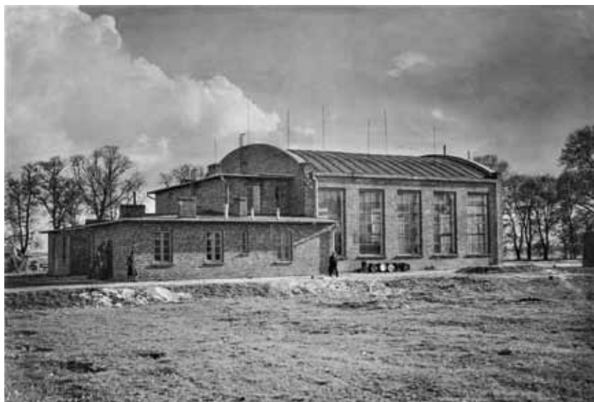
Elektrownia na lotnisku w Dęblinie zaopatrująca cały kompleks w tym wieże ciśnień i ujęcie wody w energię elektryczną. Fot. archiwum MSP w Dęblinie
