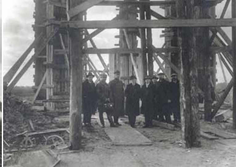
Na zdjęciu wizytacja budowy wieży ciśnień, być może jedna z komisji odbiorczych. Pierwszy z lewej inż. Michał Trembecki. Fot. archiwum MSP w Dęblinie
