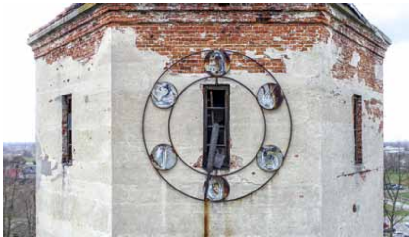
Wodowskaz przy zbiorniku wody w wieży ciśnień, zamontowany po 1945 r. Fot. M. Płotkowiak
