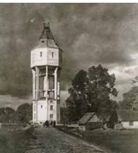
Wieża ciśnień w Dęblinie, stan 1929 r. Fot.: F. Sevre; ze zbiorów MSP w Dęblinie
