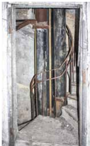
Spiralna klatka schodowa w osi wieży ciśnień. Widoczne rury wodne. Fot. M. Płotkowiak
