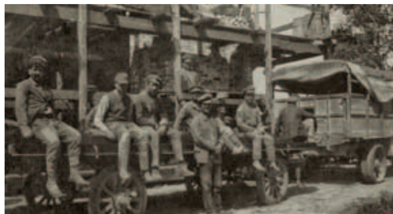
■ DĘBLIN. JEŃCY BOLSZEWICCY PO OFENSYWIE 16 VIII 1920 R. BYLI LOKOWANI W TWIERDZY DĘBLIN, MŁYNKACH ORAZ W KOSZARACH W ZAJEZIERZU. W LATACH 1920–21 W DĘBLIŃSKIM SZPITALU WOJENNYM, ZORGANIZOWANYM NA BALONNIE JESZCZE PRZEZ AUSTRIAKÓW W 1915 R., ZMARŁO Z RAN I CHOROÓB (ZAPALENIE PŁUC, TYFUS, CZERWONKA, GRUŻLICA, A NAWET CHOLERA) 324 JEŃCÓW, KTÓRYCH POCHOWANO NA CM. BALONNA. POZOSTAŁYCH SUKCESYWNIE ROZWOŻONO DO STAŁYCH OBOZÓW JENIECKICH
