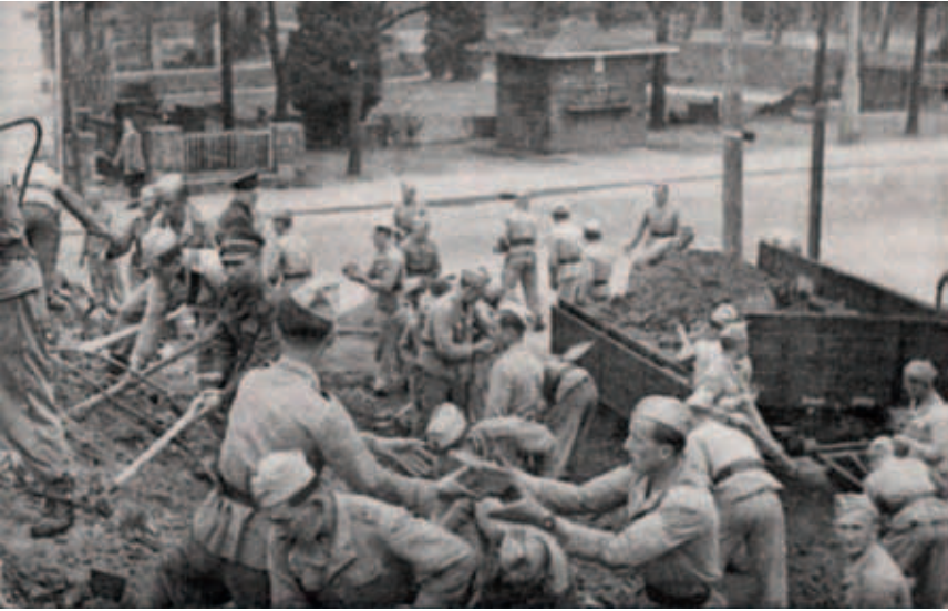
▲ LATO 1951 R. – KADRA I PODCHORĄŻOWIE OSAPŁOT. PODCZAS ODGRUZOWYWANIA MIASTA W OKOLICACH DZISIEJSZEGO CK 105. W TLE ULICA ZWYCIĘSTWA I PARK Z WIDOCZNĄ W GŁĘBI CHARAKTERYSTYCZNĄ ALTANĄ (KRONIKA OSAPŁOT. NR 0438)
