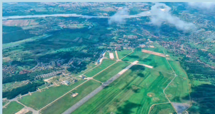
■ MIASTO DĘBLIN Z LOTU PTAKA, FOT. JACEK ZAGOŹDŻON
