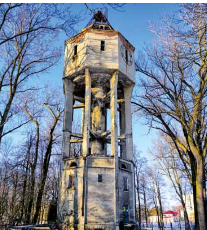
WIEŻA OBECNIE, 2017 R., FOT. P. PAWŁOWSKI
