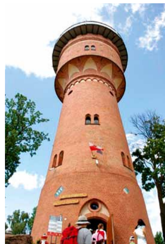
GIŻYCKO – WIEŻA CIŚNIEŃ PO PRZEBUDOWIE MIEŚCI MUZEUM I KAWIARNIĘ, FOT. P. PAWŁOWSKI
